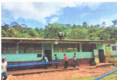
Foto 1: cambiando costaneras picadas por el oxido
