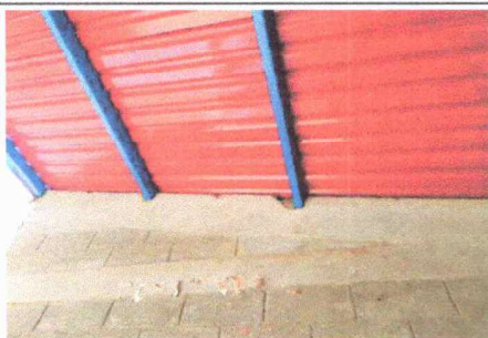
Foto 3: se cambio las costaneras del corredor oxidados
